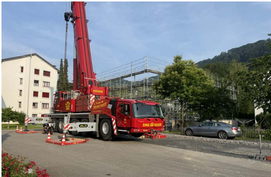
Erstellung Mobile Schulräume Au
