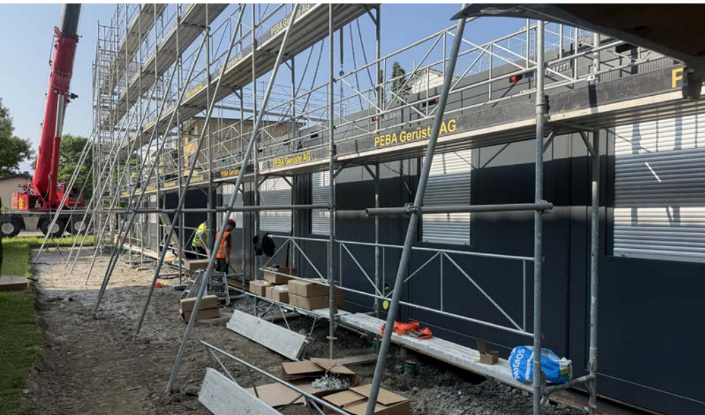
Erstellung Mobile Schulräume Au
